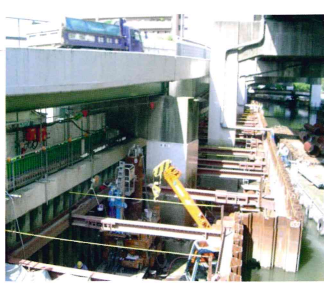
城北川改修工事その62 大阪市 鋼管杭φ700~1000mm, L=21.5~22.0m 102本, 3~12本継ぎ
