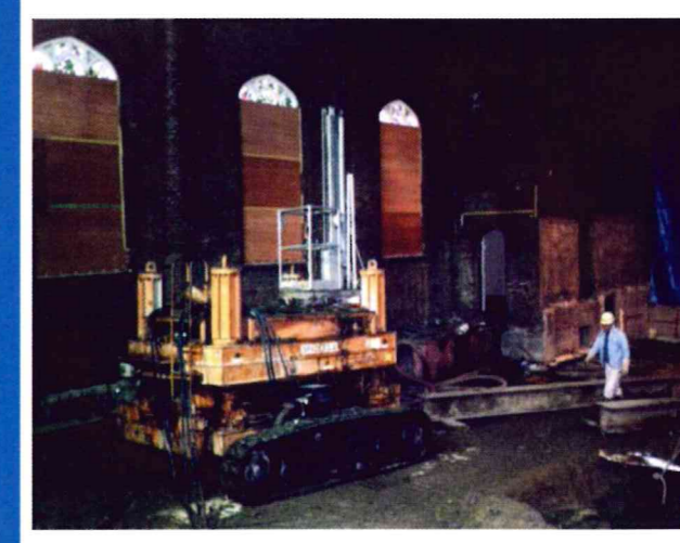
川口教会震災復旧工事 大阪市 鋼管杭φ600 700 800mm L=33.2m, 18本
