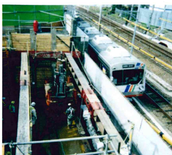
上原跨線橋工事 静岡県 鋼管杭φ600mm, L=6.5m, 12本
