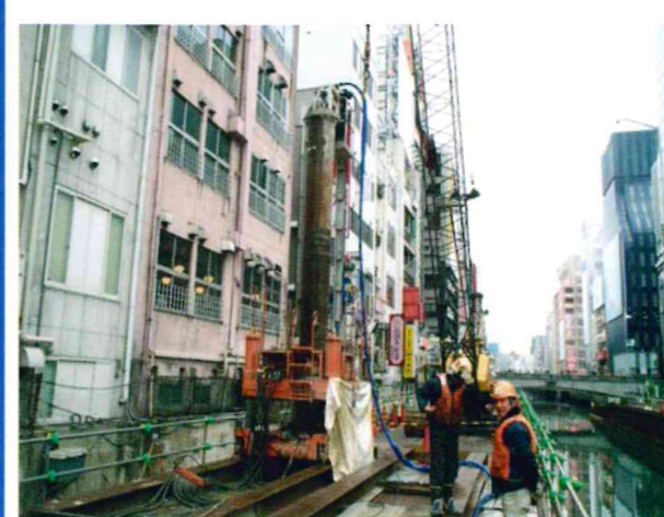
道頓堀川水辺整備工事 大阪市 (戎橋~太左衛門橋) 鋼管杭φ600mm, L=11.0~14.0m, 146本
