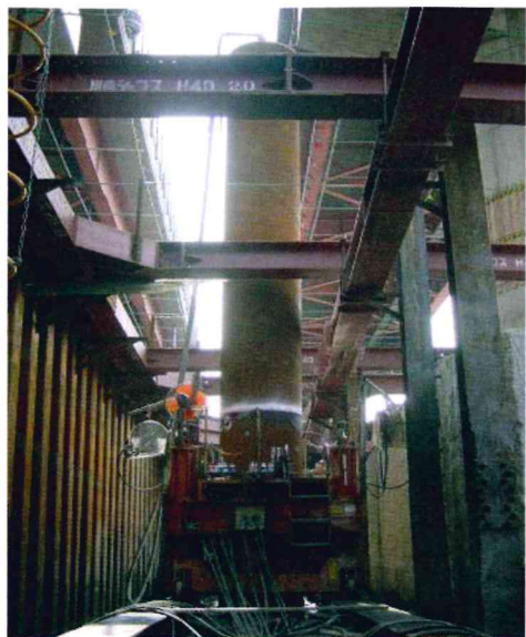
東京外環自動車道三郷JCT東工事 埼玉県 鋼管杭φ1000mm, L=44.5~46.0m 101本, 4~5本継ぎ
