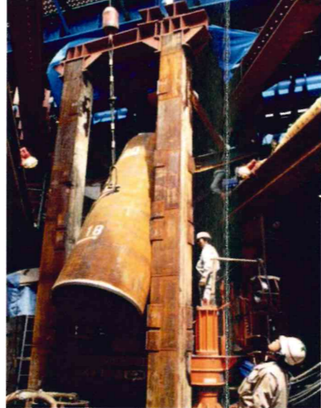
横浜市委託：金沢文庫駅~ 神奈川県 金沢八景駅間宮川橋梁架替工事 鋼管杭φ1200mm, L=31.2m, 90本, 9本継ぎ
