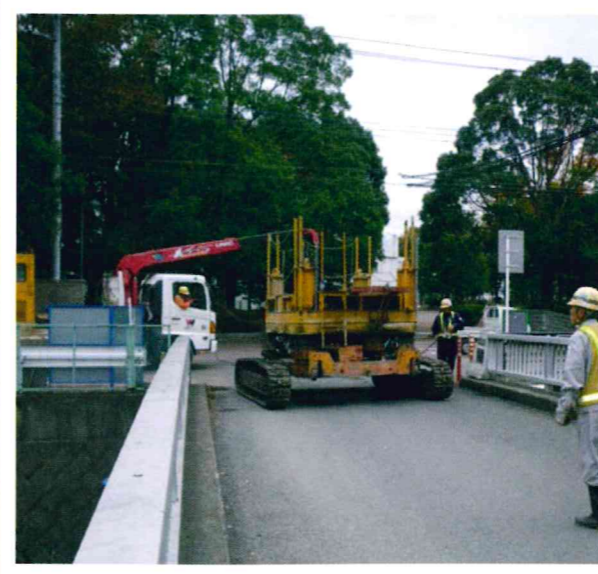
重量制限のある橋梁を対岸移動して施工
