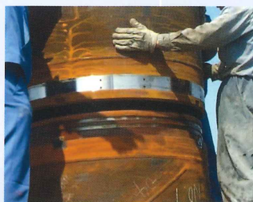
機械式継ぎ手施工
