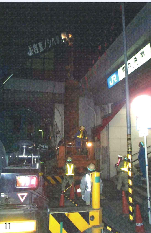
機械式継ぎ手施工
