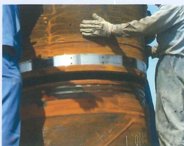
機械式継ぎ手施工
