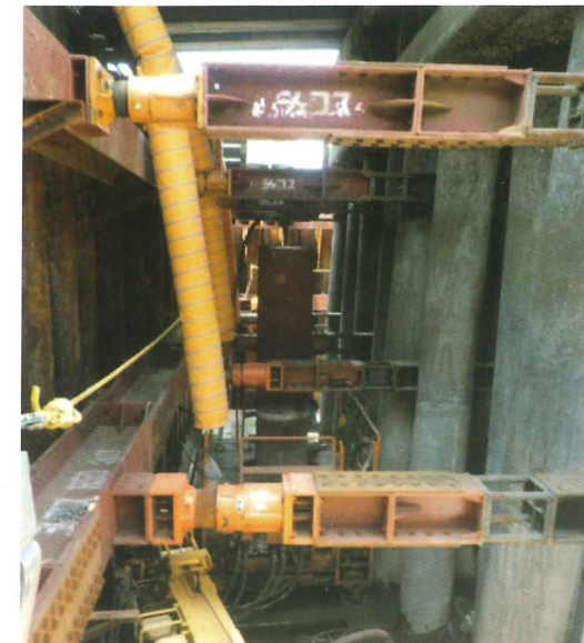
港橋耐震補強(その1)工事 兵庫県 鋼管杭φ700mm, L=17.5m, 14本, 7本継
