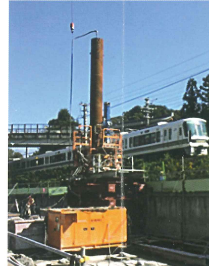
木津東バイパス工事(JR跨線橋) 京都府 鋼管杭φ600mm, L=18.5m, 27本, 2本継
