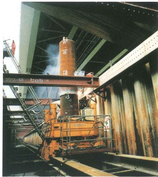
城北川改修工事その33 大阪府 鋼管杭φ800mm, L=20.0~21.5m 58本, 6~11本継
