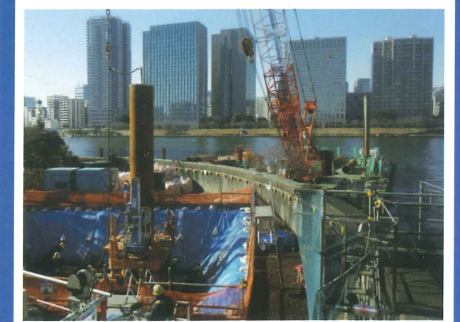
テラス連絡橋(大島川水門)工事 東京都 鋼管杭φ700mm, L=21.5~24.5m, 7本, 3~4本継
