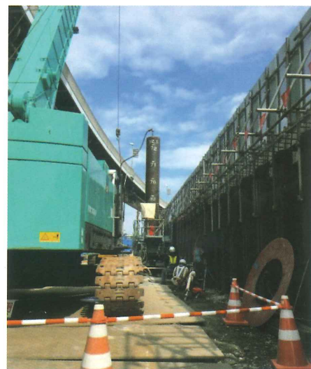
舞浜立体海側下部その3工事 千葉県 鋼管杭φ800mm, L=57.0~72.5m, 54本, 4~18本継
