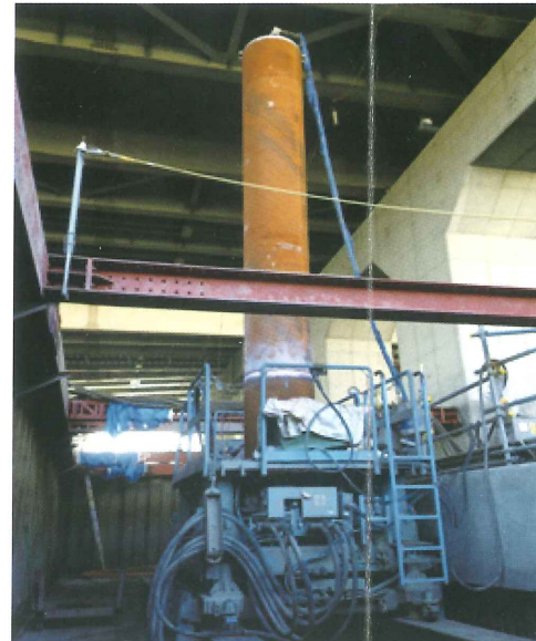
東京外環自動車道三郷JCTG'ラフ'橋工事 埼玉県 鋼管杭φ800mm, L=42.0~59.5m, 343本4~18本継 鋼管杭φ1000mm, L=44.5~51.0m, 25本, 4~16本継
