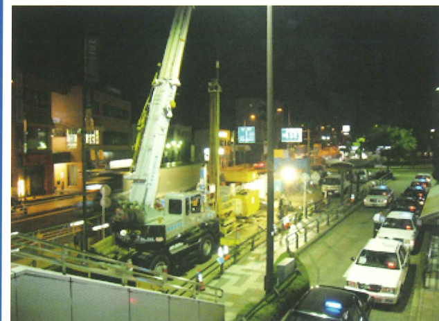
国道246号愛甲宮前交差点Pデッキ工事 神奈川県 鋼管杭φ600mm, L=27.5~28.5m, 16本, 3本継
