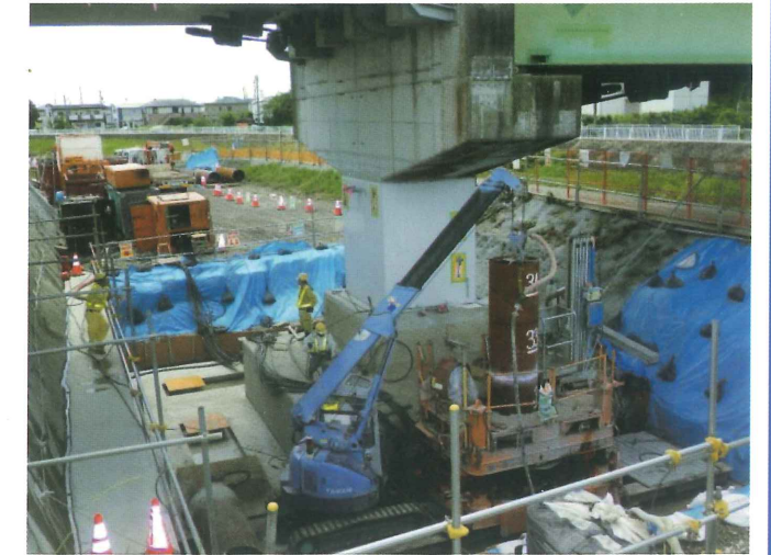
葉梨高架橋補強補修工事 静岡県 鋼管杭φ800mm, L=34.5m, 10本, 8~18本継
