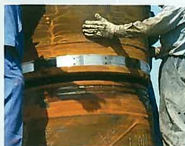
機械式継ぎ手施工
